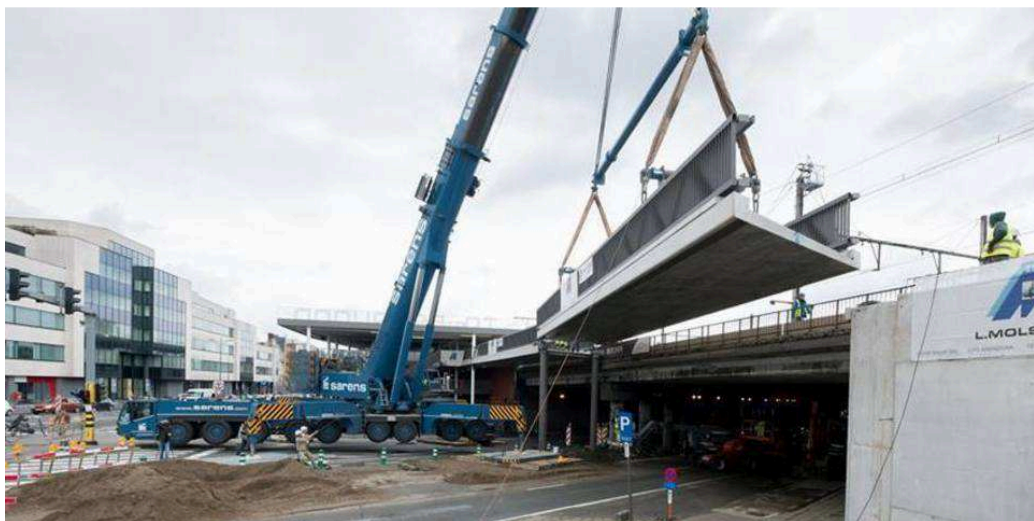
Foto genomen tijdens de plaatsing van de fietsbrug.
